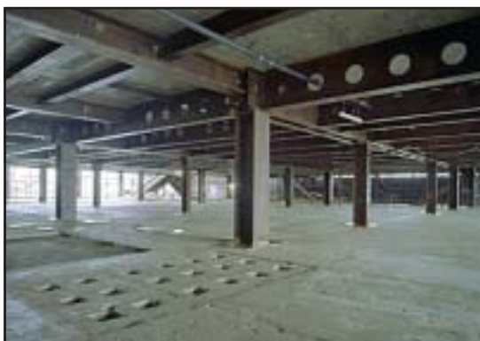
Palast der Republik (structural beams) photo: Verein Zwischenpalastnutzung
